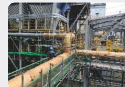
배관 보온재 시공
