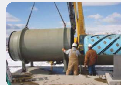
1차 PIGGING (FOAM PIG) 관통테스트 / 초기 이물질 제거
